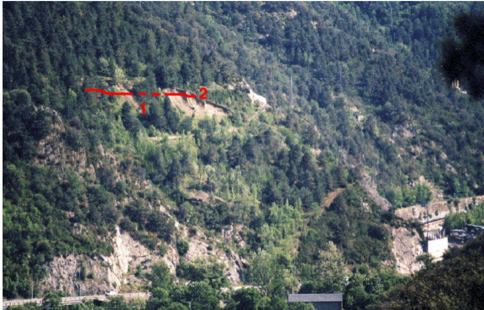
Aflorament de la gravera de Cal Tulse, evidències d'inestabilitats (1 Dins dels col-luvions, 2 Falla que afecta als col-luvions)
