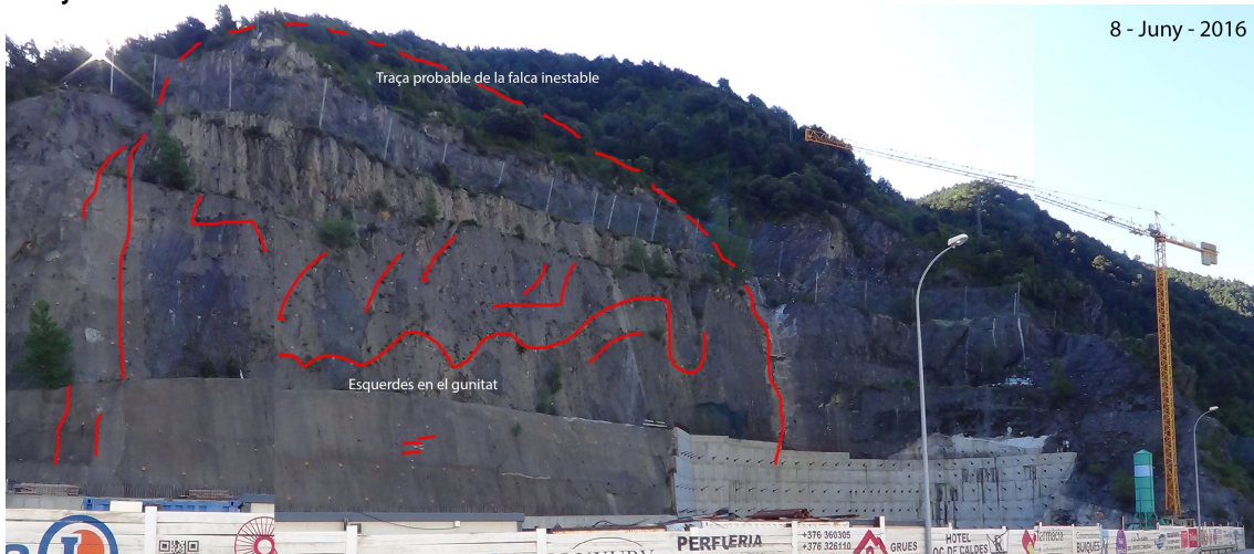
Aspecte de la inestabilitat que afecta el desmunt rocós.
